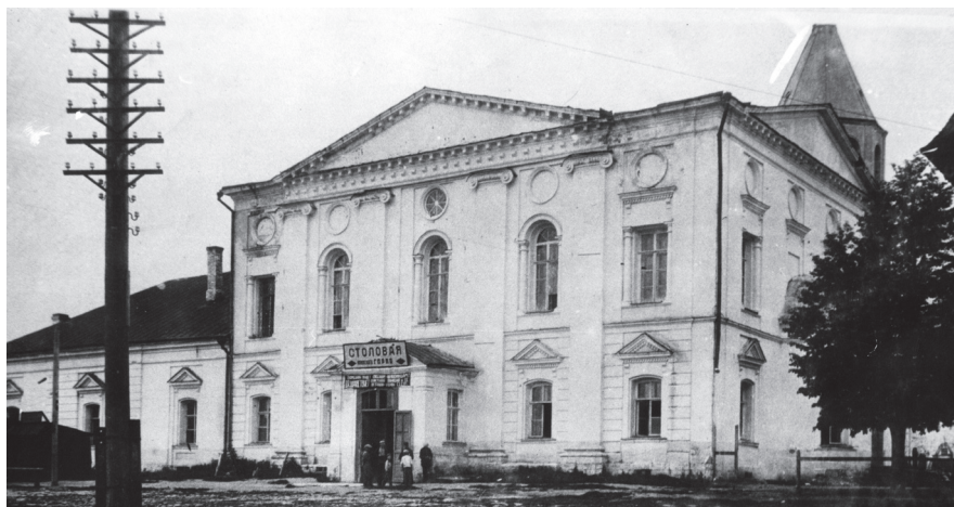
Это – почти неузнаваемый вид южного фасада Троицкого собора. Водосточные трубы разрушены, верхняя часть фасада почернела и стала рушиться.
